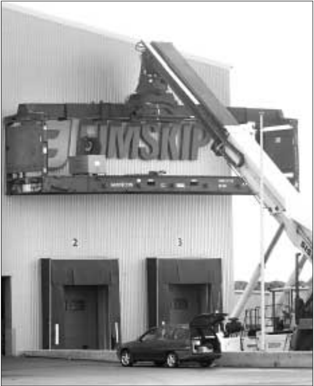
Eimskip í Føroyum riggar av eftir samanleggingina við Skipa- felagið Føroyar, og her verður skeltið á nýggja bygninginum hjá Eimskip á Skansabryggjuni tikið niður
