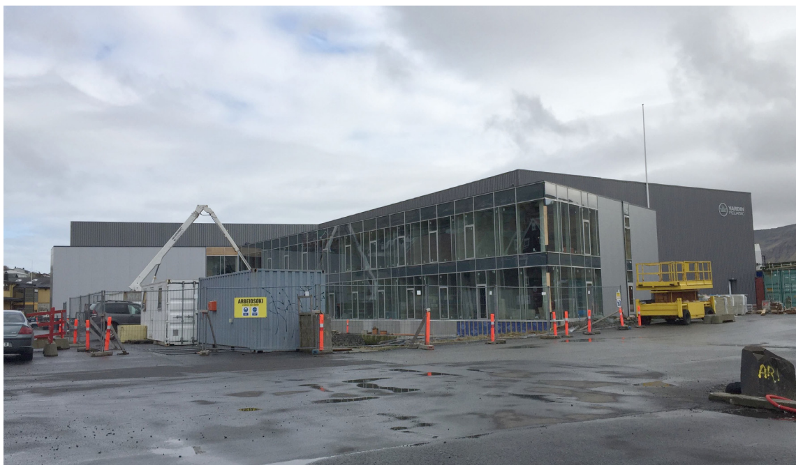
– Tá alt verður liðugt, túnið er gjørt, og byggiplássið verður riggað av, fer alt at siggja nógv betri út, sigur Ólavur Bjarkhamar
