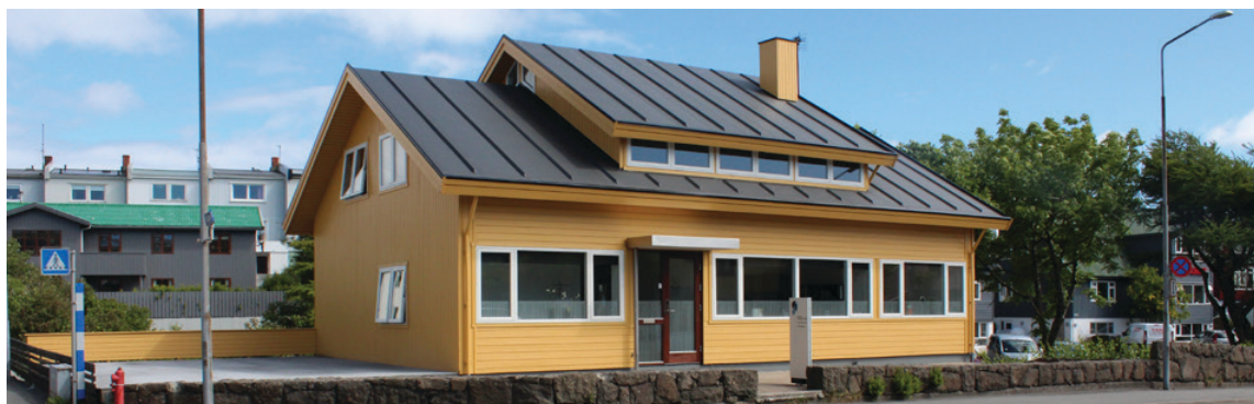
Allar kommunur er nú limir í sama felag. Kommunufelagið hevur skrivstovu í hesum bygningum
