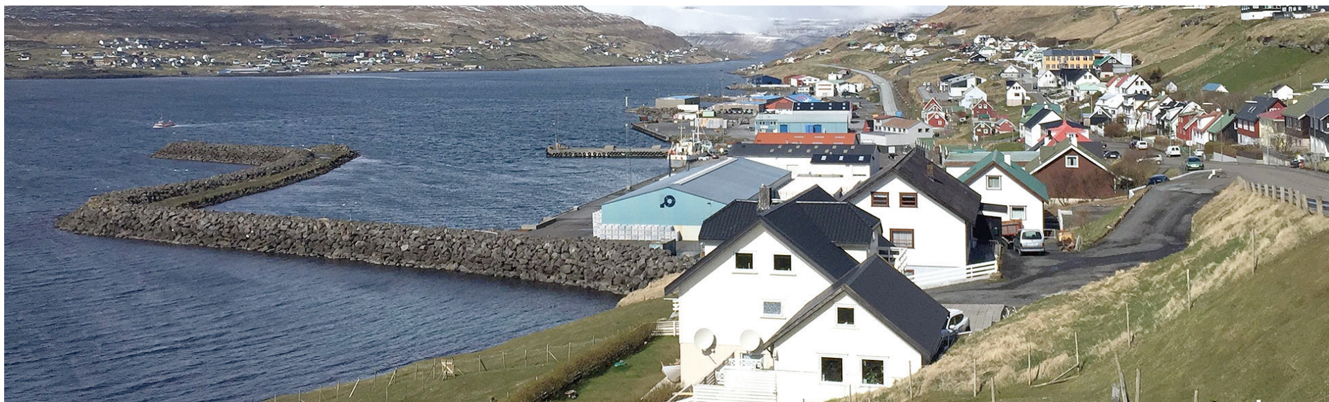
Við havnalagið á Toftum eru nógv vinnuvirki - alt frá saltfiskavirki, saltgoymslu, kassamiðstøð, plattavirki og landingarmiðstøð til timbur- og bilaverkstað
