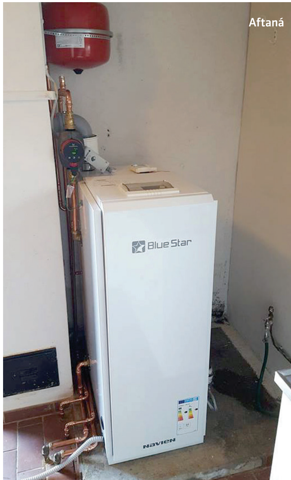
Áðrenn og aftan á at Bluestar kondensketilin er settur upp
