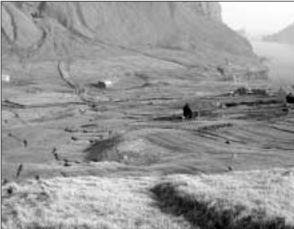
Tilboð eru komin inn upp á arbeiðið at gera tunn­ilsinntakið í Gásadali liðugt
