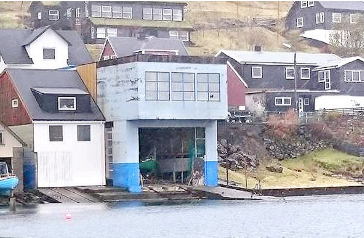
Í kjallaranum í bygninginum hjá EL-Net í Vestmanna er ein dráttur og ein lyfta, har bátar eigarar kunnu leiga seg inn og taka bátin upp og gera umvælingar og viðlíkahald uppá bátarnar
