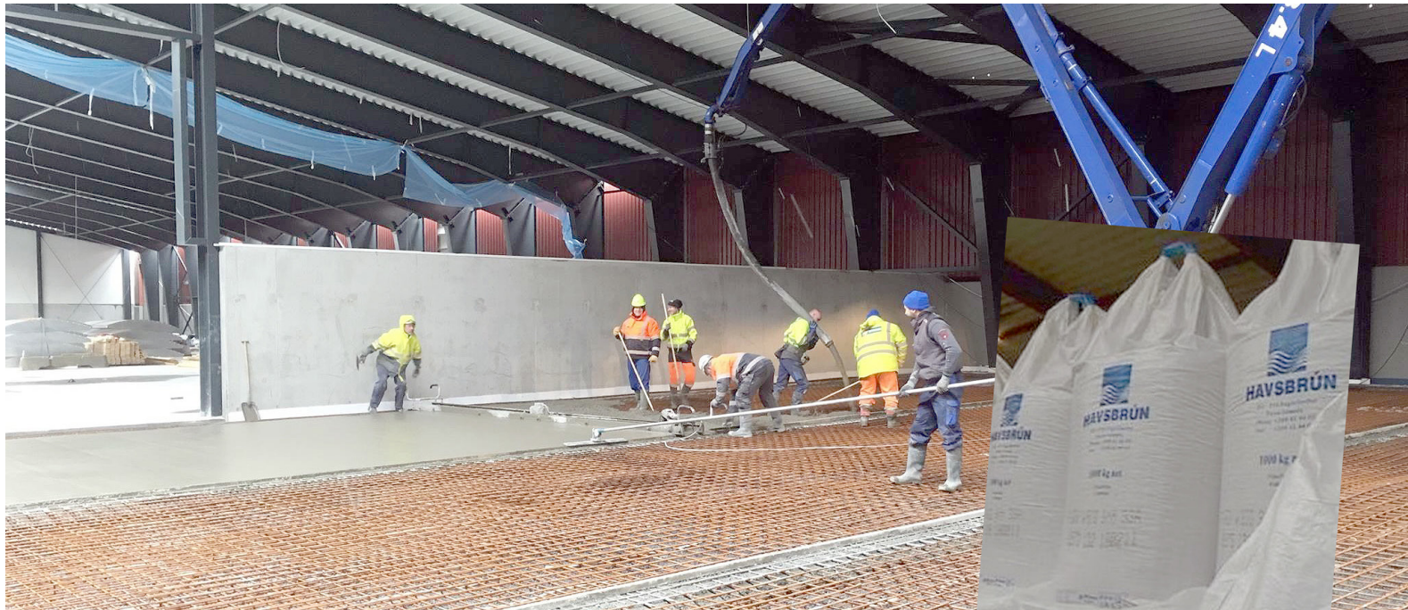
Myndin er av nýggju fódurgoymsluni hjá Havsbrún, har J&K Petersen eru í holt við at stoypa 900 fermetra stóra gólvið Mynd: J&K Petersen
