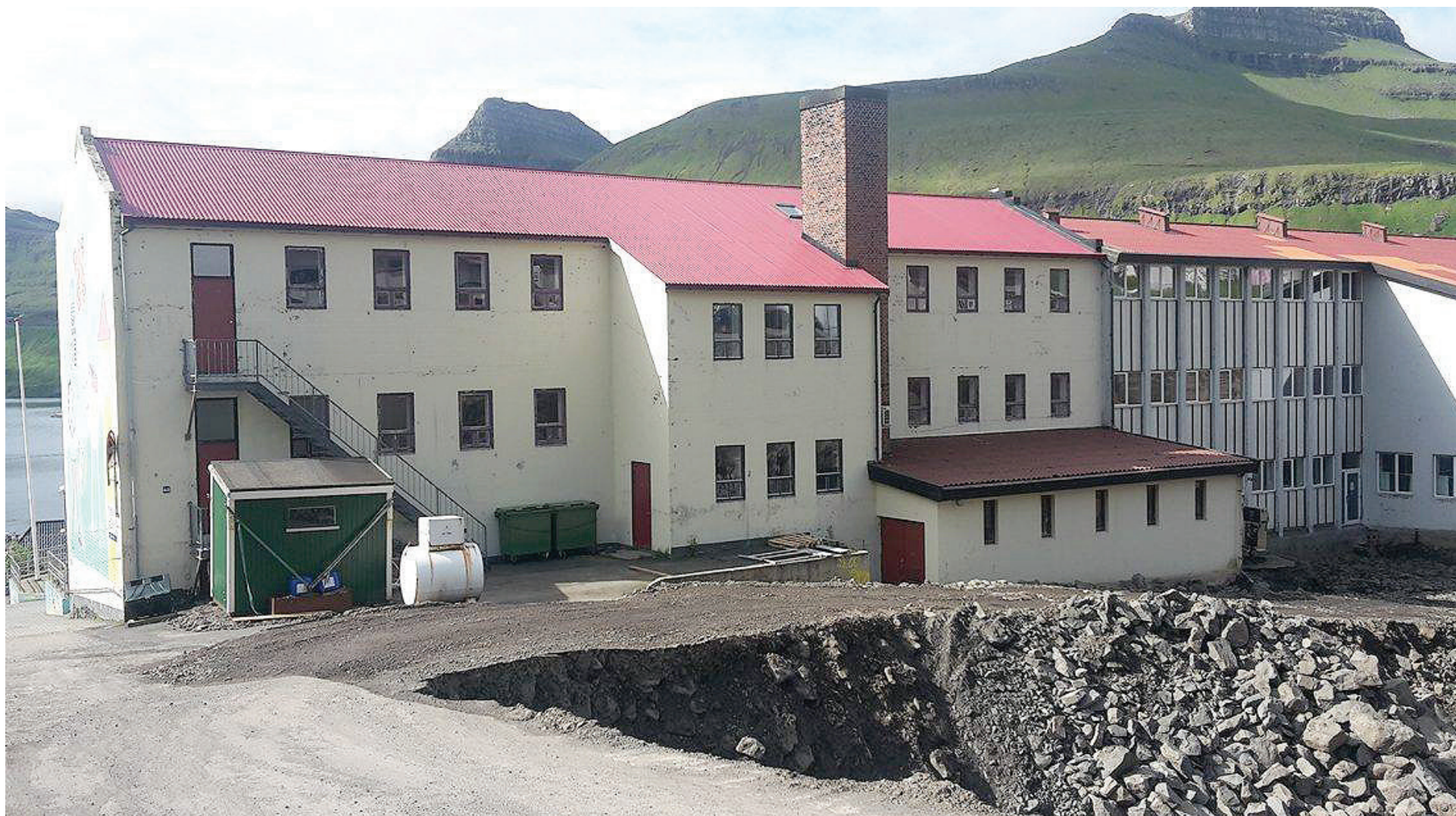
Arbeiðið at grav út til nýggja barnaskúlan í Fuglafirði er um at vera liðugt
