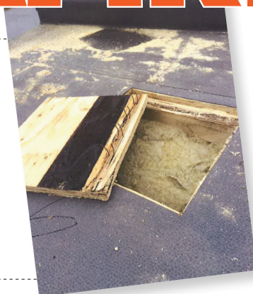
Royndir á tekjuni vísa, at konstruktiónin er vát.
