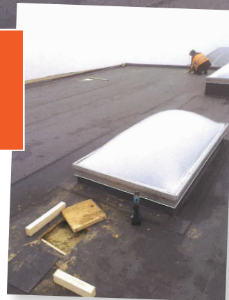
Royndir á tekjuni vísa, at konstruktiónin er vát.
