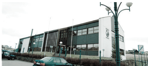
Lögreglan mátti fara úr gomlu støðini (ovast) í 2011, tí tjúkkur blámusoppavøkstur var í bygninginum. Í 2013 varð blámusoppur staðfestur í nýggju støðini (mittast), og longu áðrenn lögreglan er flutt inn, er soppur staðfestur í komandi lögreglustøðini (niðast)
