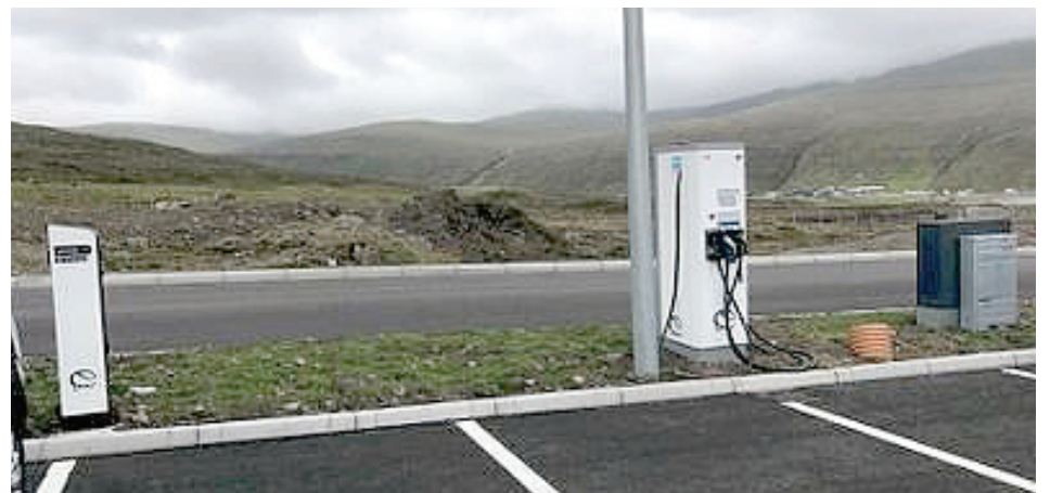
Løðistøðin á flogvøllinum er ein sonevnd »Quick Charge« løðistøð, sum kann løða tveir elbilar í senn upp á 80 prosent eftir umleið 20 minuttum
