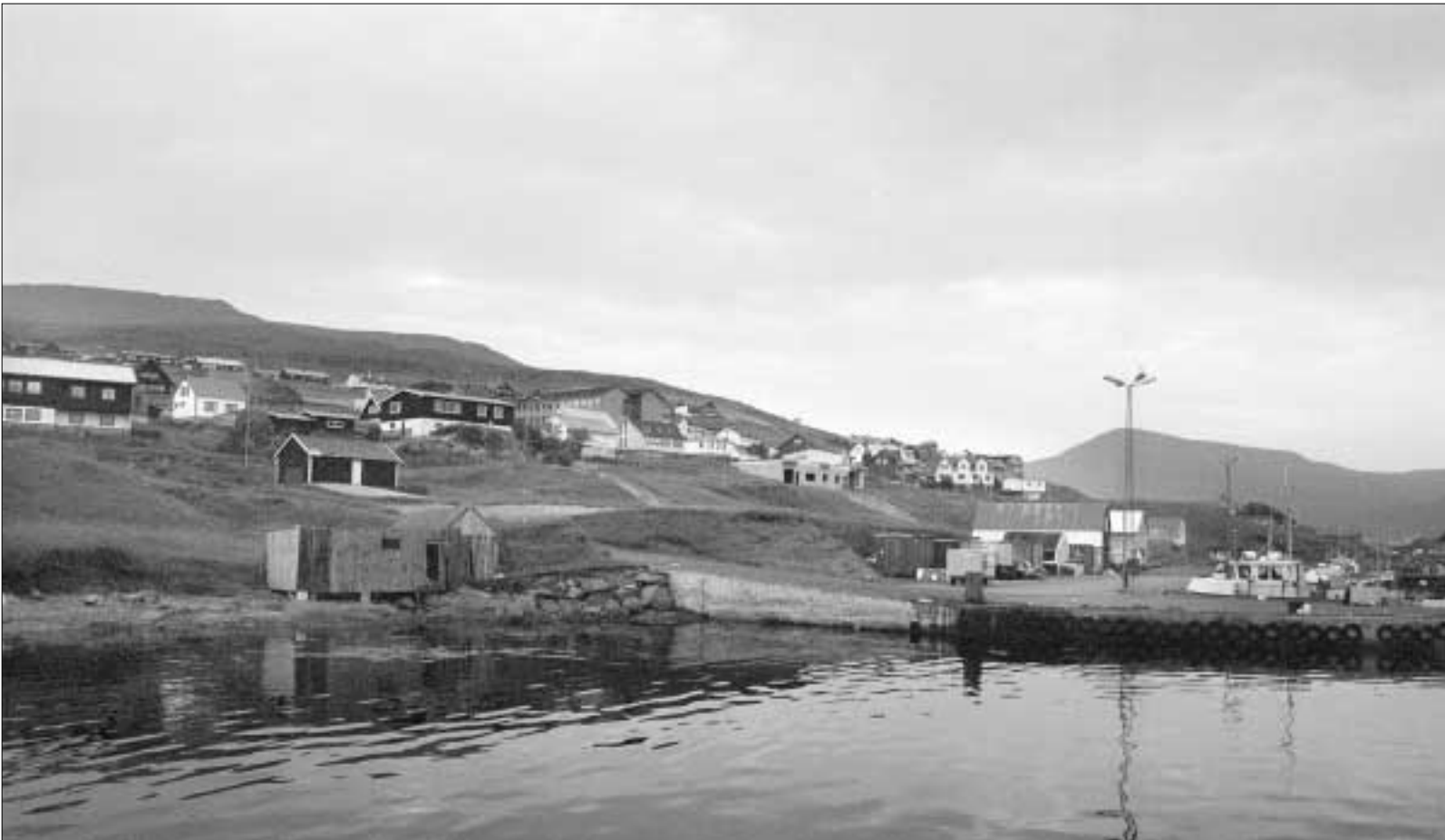
Sjóvar Kommuna fer at byggja egningskúrar á havnarlagnum beint innan fyri bátahylin á Strondum
