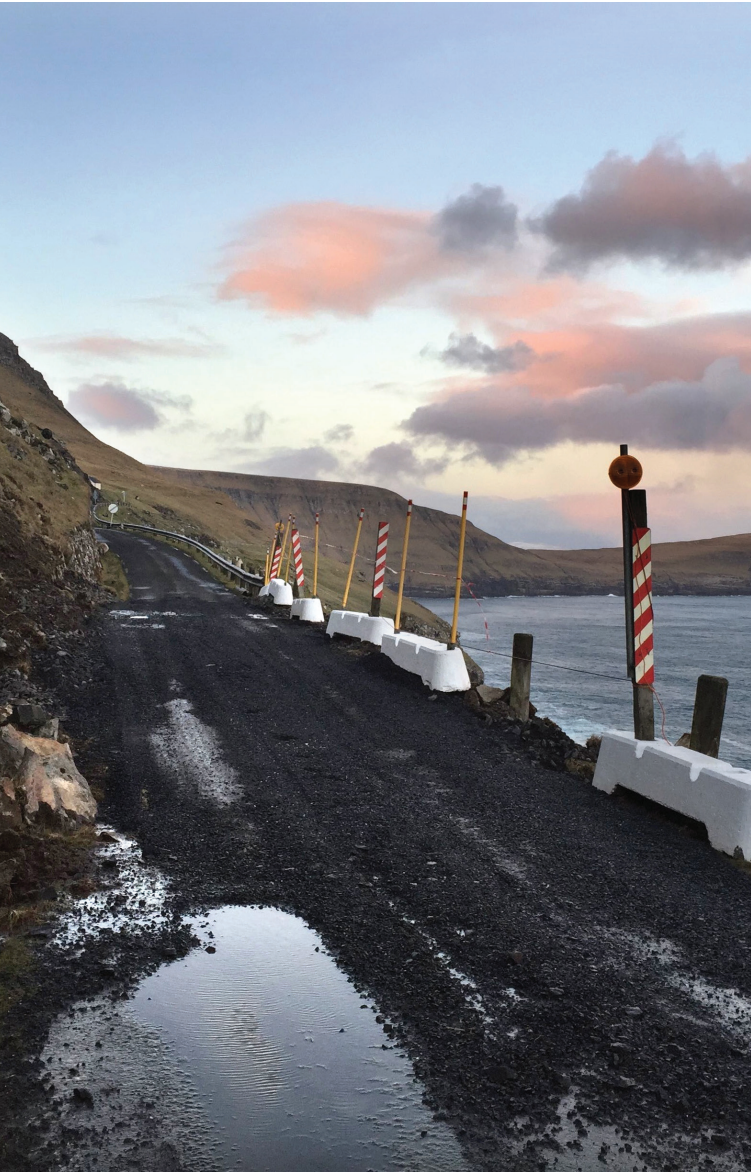
Soleiðis sær út í Dalslíð, nú arbeitt verður við at beina burtur ein stóran stein í hamrinum oman fyri, sum hugsandi stóð til at leypa. Her er eingin bilaverja, bert nakrir betongklossar Mynd: Vilmund Jacobsen
