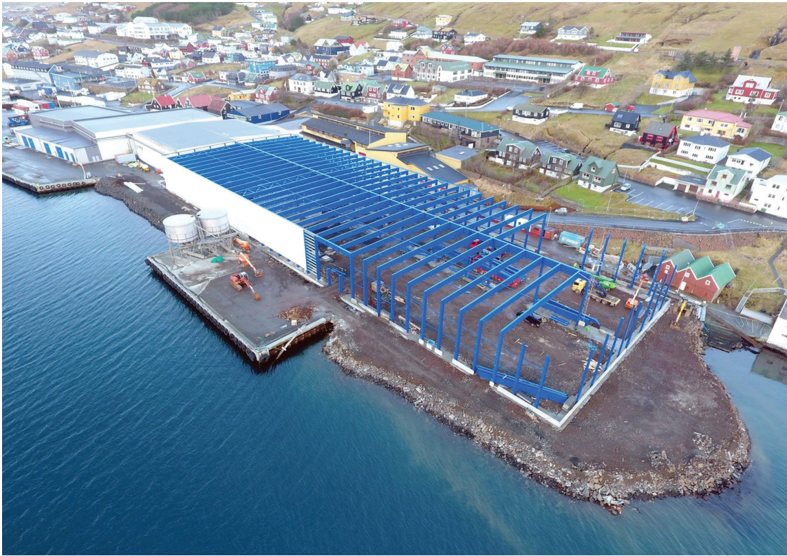
Nýggi virkisbygningurin hjá Varðanum Pelagic hevur nú veruliga tikið skap á havnalagnum á Tvøroyri. Myndina eigur Reidar Simonsen
