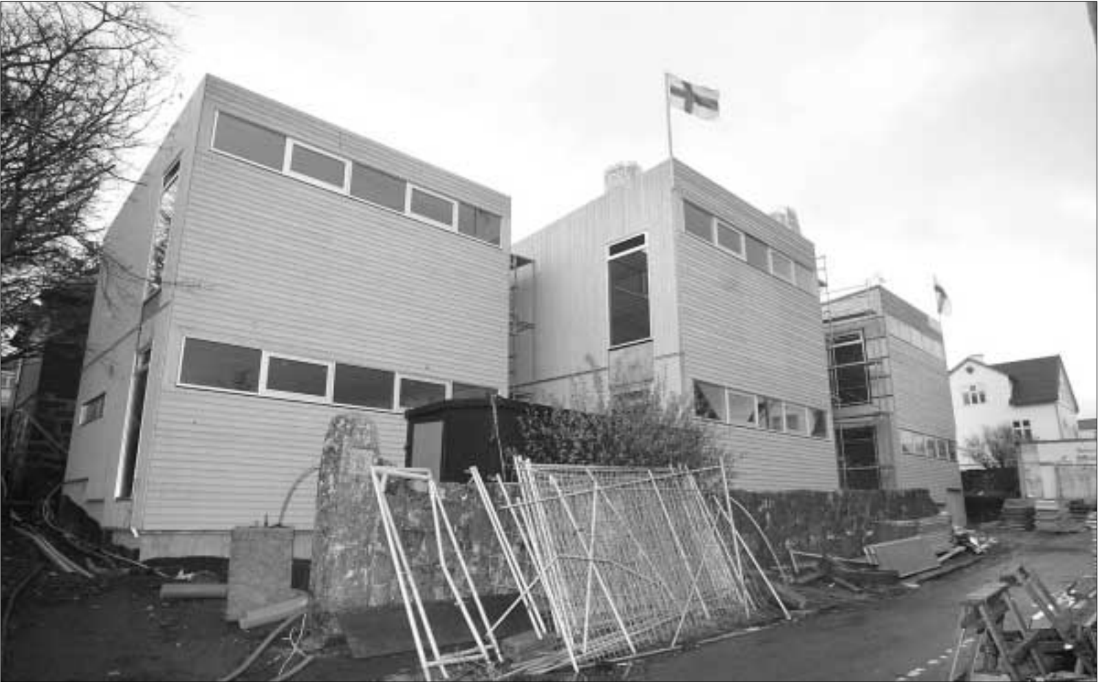
Nýggi bygningurin hjá Tórshavnar Kommunuskúla, ið komandi skúlaár skal hýsa 1., 2. og 3. flokki.
