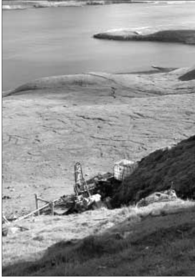
Borivognurin stóð í Brattlendi omanfyri Tjaldavík, tá ið seinastu kjarnuboringarnar vórðu gjørdar. Í tilmæli sinum fer Landsverk at viga ein tunnil niðri í dalinum upp ímóti einum tunli, sum Landsverk sjálvt mælti til at gera longri uppi
