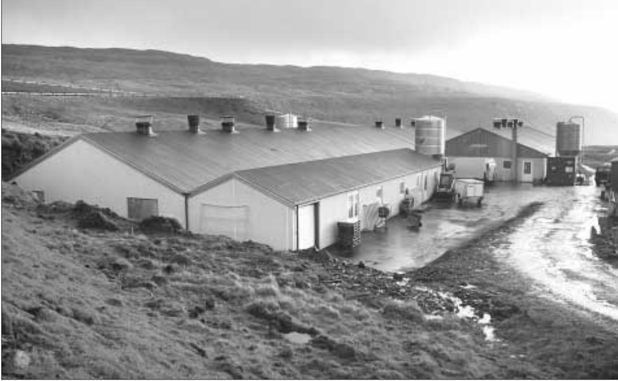
Nýggi bygningurin hjá virkinum Føroya Egg á Velbastað. Tilsamans hevur virkið nú 1250 fermetrar at ráða yvir, og 10.400 hønur eru »fluttar inn«. Í februar kemur væntandi næsta vøran av Velbastað, nevnliga høsnaðkjøt.
