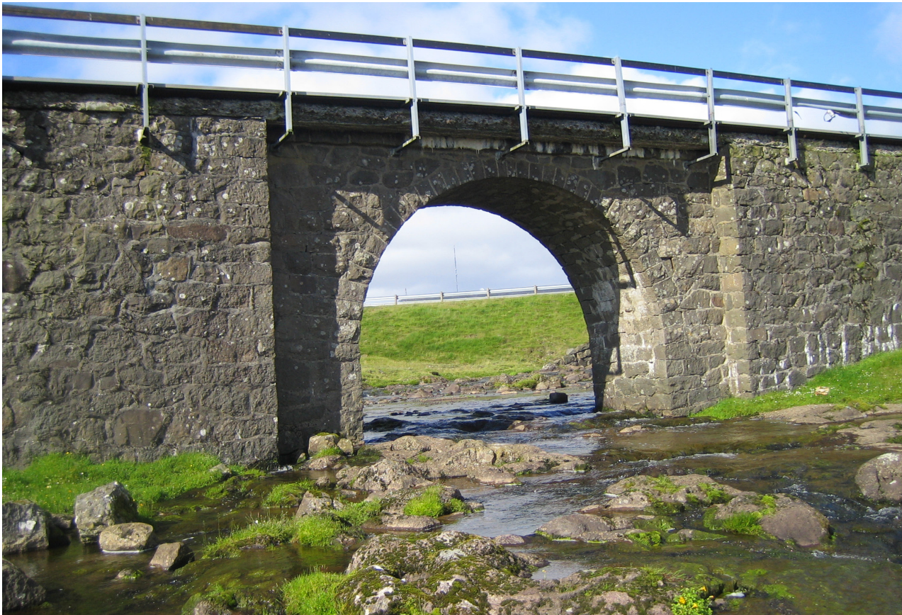
Gamla brúgvín um Sandá úti í Havnardali skal setast aftur í sín uppruna, asfaltið og bilverjan verða tikin burtur, og smiðjujarnsgelendari verður gjørdur, soleiðis at brúgvín fær sítt upprunasnið
