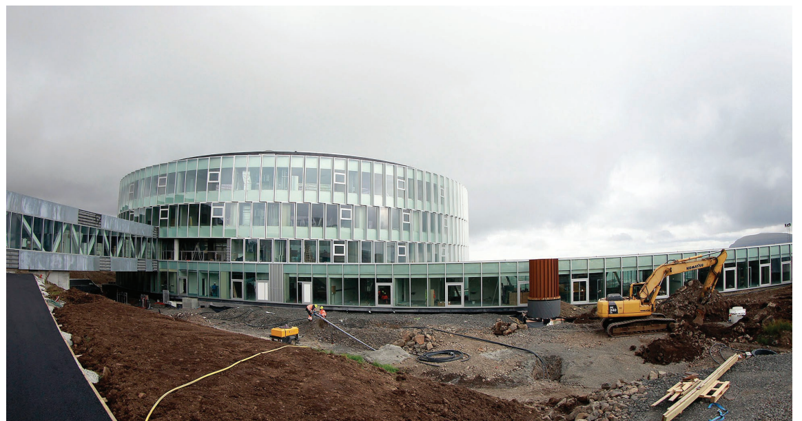
Av tí at Asfaltverkið fer í summarferiu, er ikki víst, at alt økið rundan um skúlan verður liðugt asfalterað til skúlaársbyrjan
