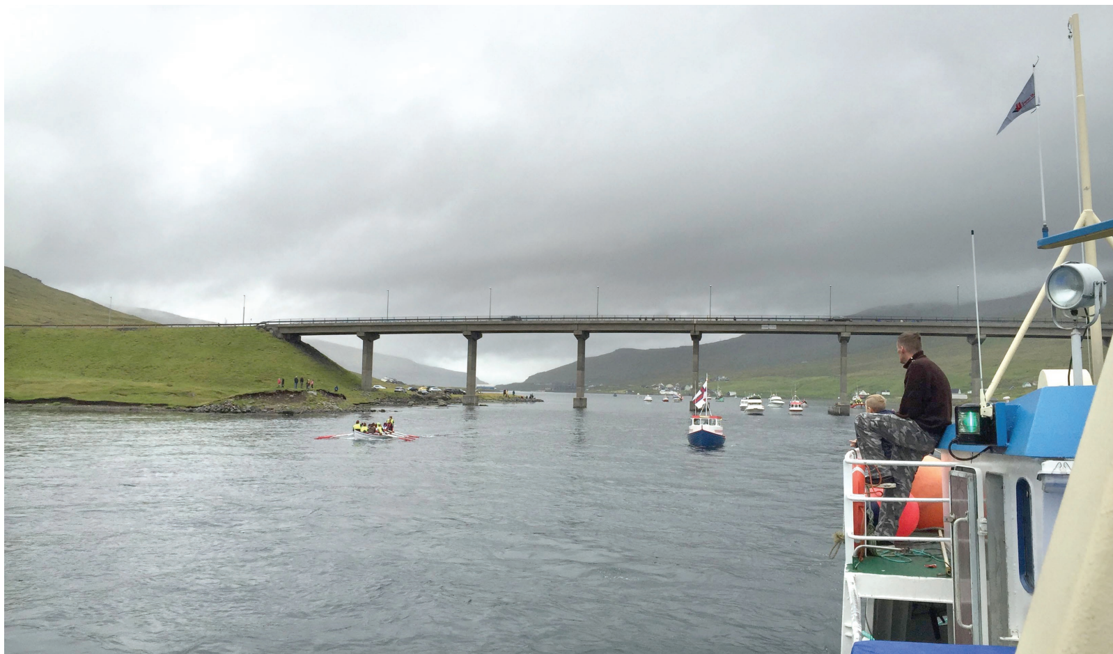
Tað er altíð ein avbjóðing at leiða bátafylgið um trongan undir brúnni, men er veðrið gott, og lótan verður passað til streymin, plagar alt at ganga upp á stás
