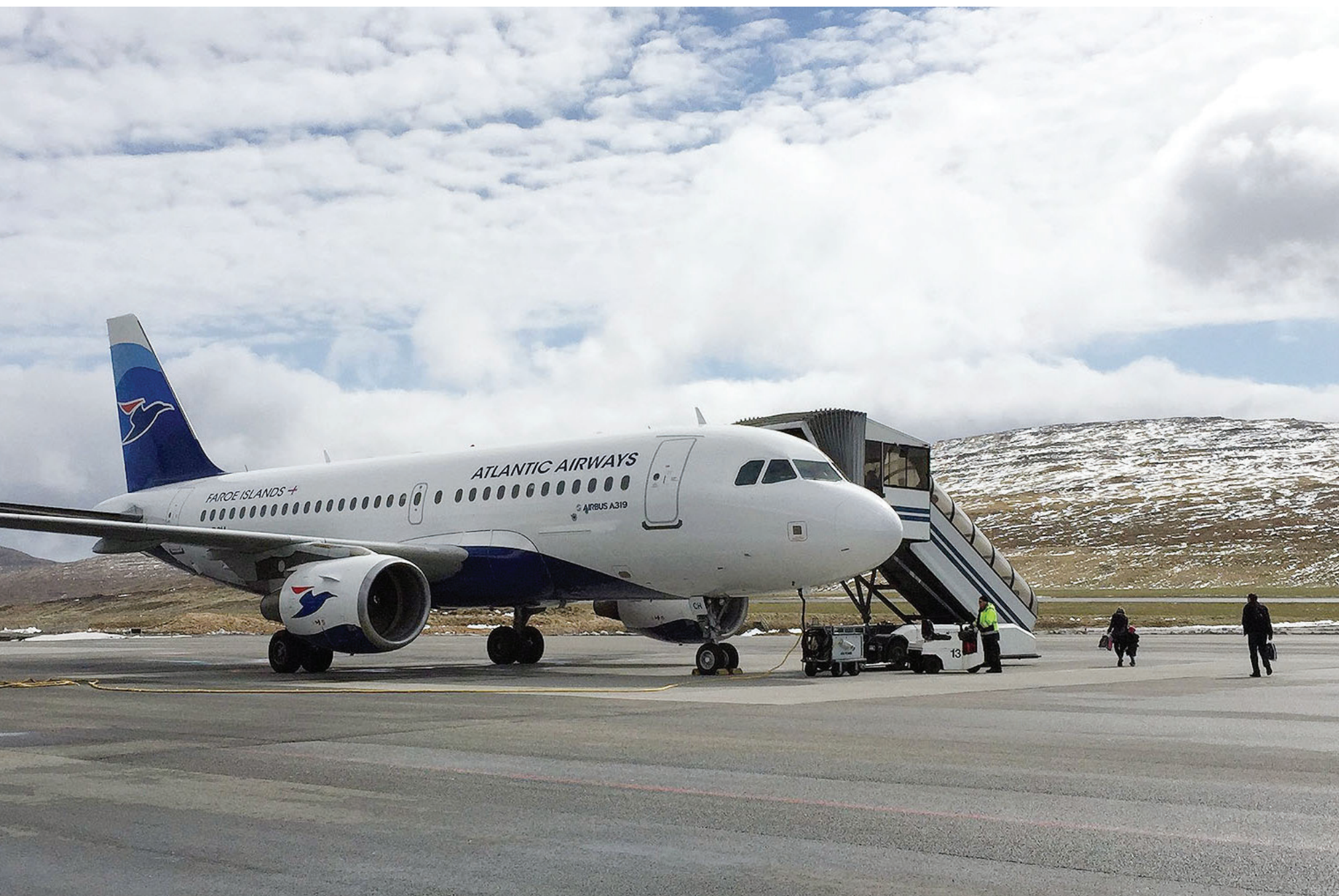
Terminalurin í Vága Floghavn er undir trústi og má byggjast út, áðrenn tað verður ov trøngt
