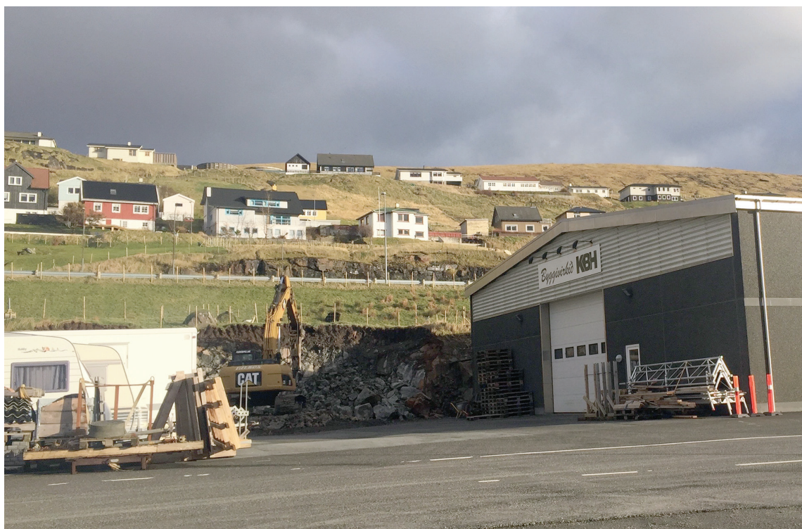
Tað er her á havnalagnum á Toftum, at byggivirkið KBH hevur sína støð. Nýggja tjaldhøllin skal byggjast beint norðan fyri verandi bygning
