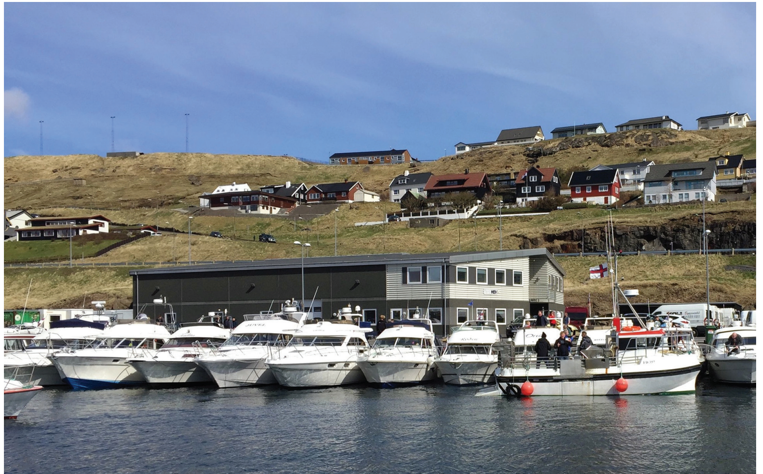
Her er Nes kommuna í holt við at gera lendið klárt, soleiðis at byggivirkið KBH kann fara í holt við at planera og stoypa fundament til nýggju tjaldhøllina
