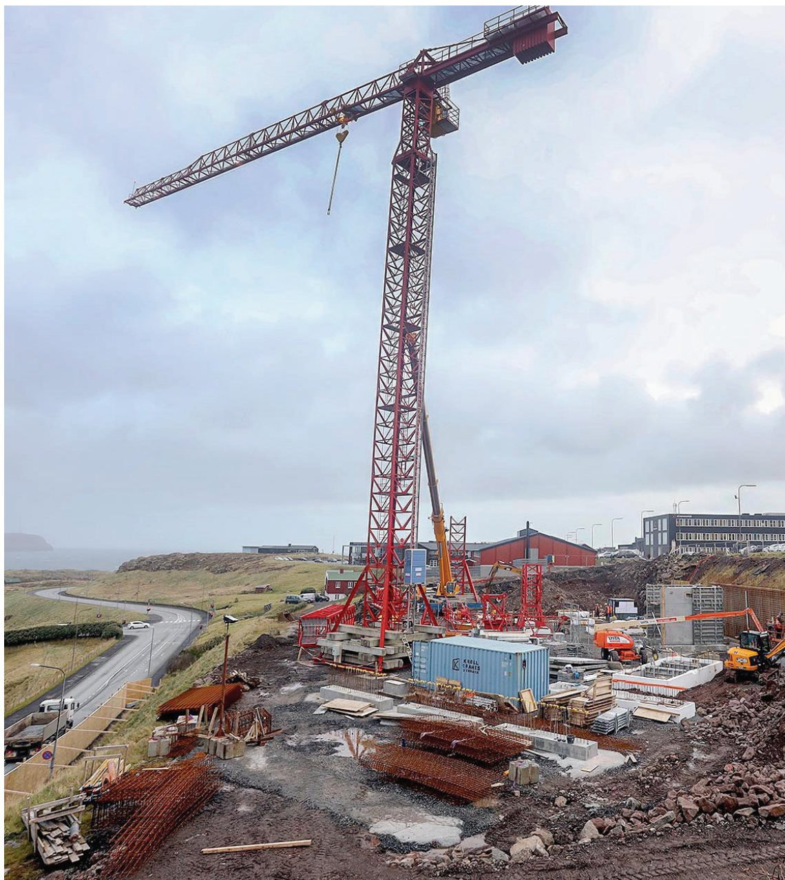
Fólk hava lagt til merkis, at ein rættiliga stórir kranar er á byggiplássinum við Staraveg, har Húsavarðartænastan í hesum døgum er í holt við at byggja hotell fyri Føroya Lívstrygging og Atlantic Airways. Mynd: Álvur Haraldsen
