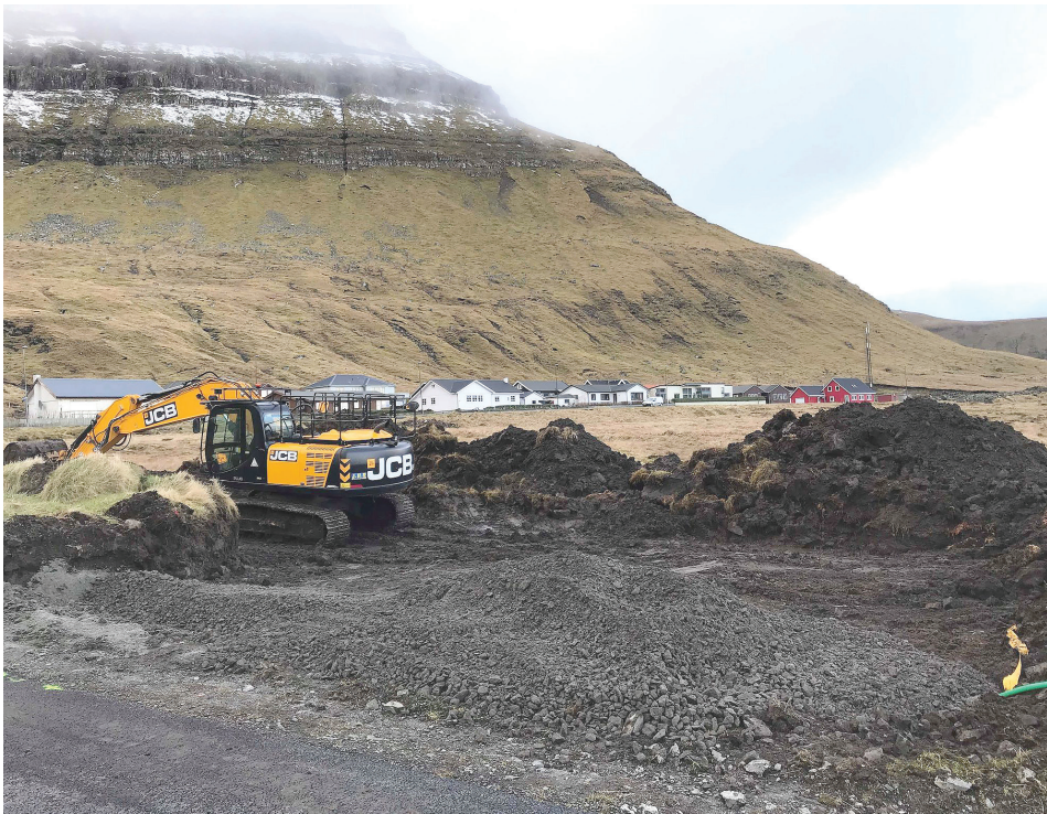
Í síðstu viku byrjaði entreprenørfyrirøkan JHR at grava út fyri átta grundstykkjum á Kambsdali
