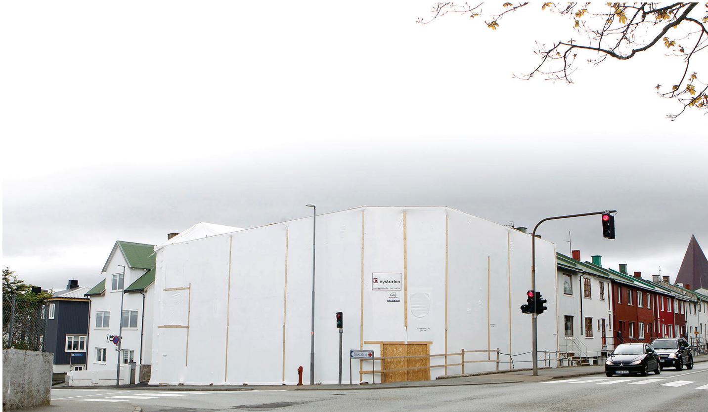
Við Jóannesar Paturssonargøtu í Havn hevur verið arbeiðt í drúgva tí. Har hevur Krymptiplast sett upp dúk, so at handverkararnir kunnu arbeiða turrir innanfyri
