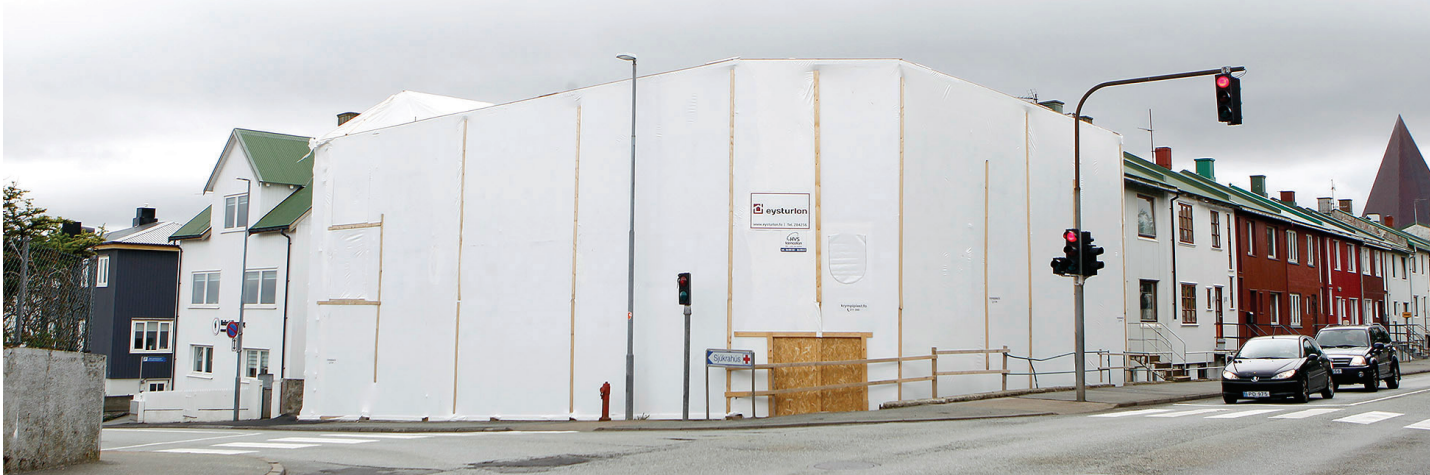
Við Jóannesar Paturssonargøtu í Havn hevur verið arbeiðt í drúgvu tí. Har hevur Krymptiplast sett upp dúk, so at handverkararnir kunnu arbeiða turrir innanfyri
