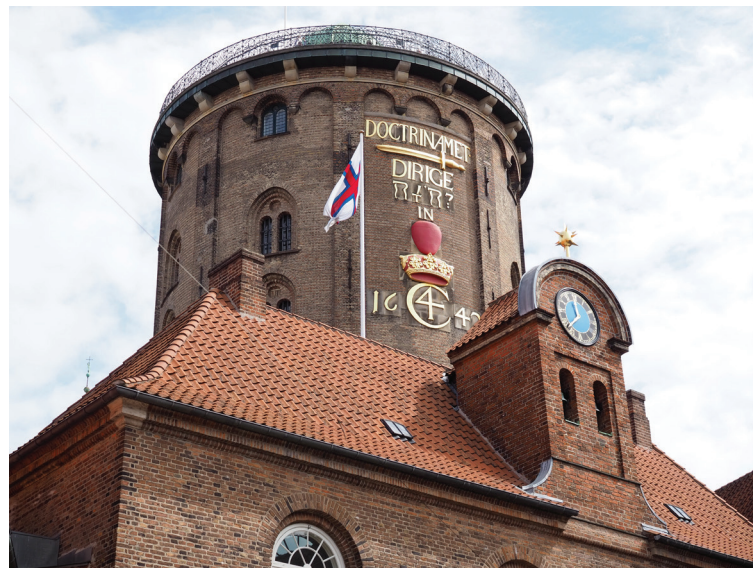
Merkið varð vundið á stong í Regensen. Aftanfýri sæst Rundatornið
