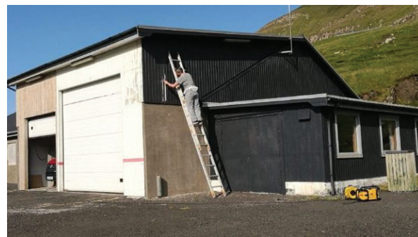
Arbeidsmenn hjá Vágs kommunu hava dagført Brandstøðina
