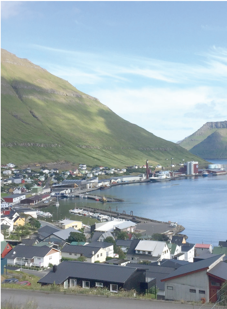
Árgangirnir við nýfðingum gerast nú eisini størri í Fuglafjarðar kommunu
