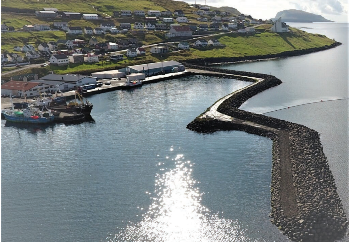
Pierurin á Toftum er longdur við 90 metrum, og hetta er í fyrsta lagi gjørt við tunnilsgróti
