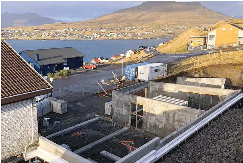
Stoypiarbeiðið til nýggja partin av frítíðarskúlanum gongur væl. Myndina eigur Fuglark
