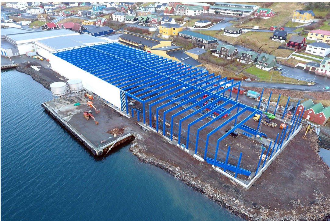
Nýggja virkið á Tvøroyri er bygt á sama stað, sum stað gamla virkið stóð. Nýggja virkið er bygt við tí vitan og teimum royndum, sum Varðin Pelagic fekk við gamla virkinum
