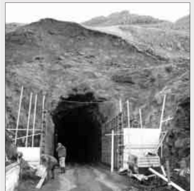
Teir arbeiða við at gera tunnilsinntakið Gásadalsmegin liðugt. Pengar eru settir av at gera arbeiðið í ár
