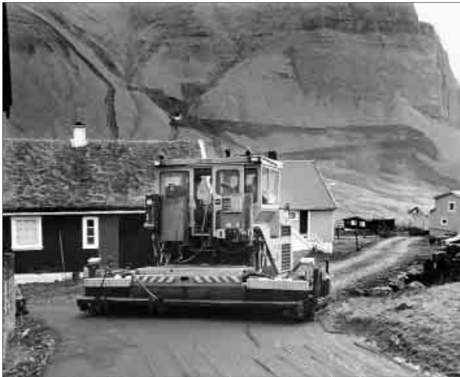
Stórar asfaltmaskinur hava seinastu dagarnar verið at sæð millum húsini í Gásadali, har asfalt er lagt á kommunalu vegirnar
