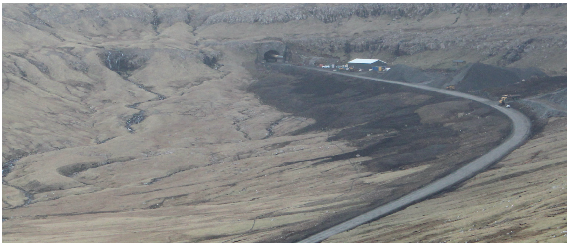
Nýggi Hvalbiartunnlin liggur munandi lægri enn núverandi tunnlin. Myndin er tikin av Kolavegnum, sum er vegurin til núverandi tunnlin, niður yvir dalin og vegin til nýggja tunnlin, har kjafturin sæst aftast í myndini
