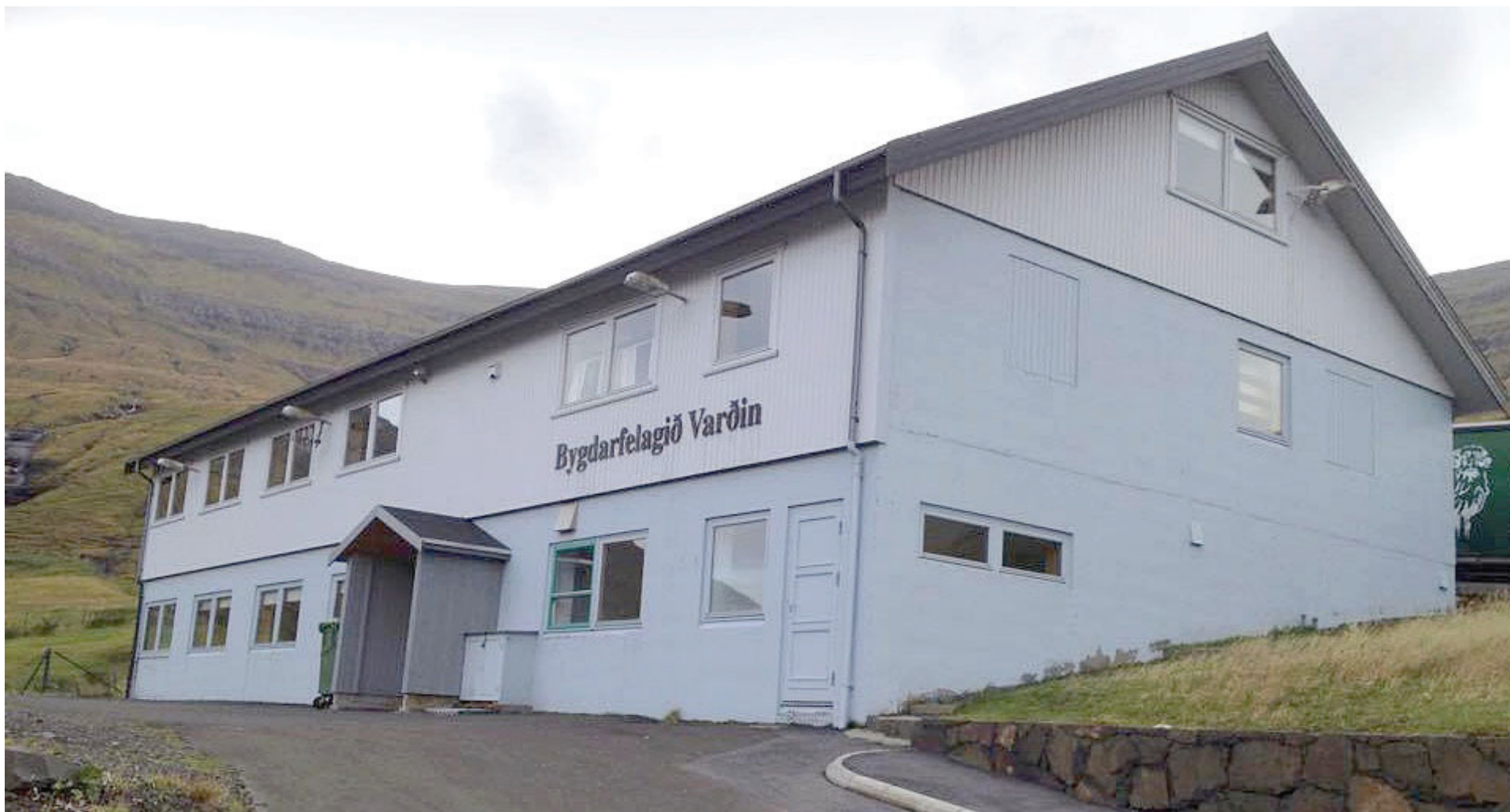
Bygdarfélagið Varðin hevur bestu umstøður, og hesar umstøður kunnu eisini leigast út til ymisk tiltøk og endamál
