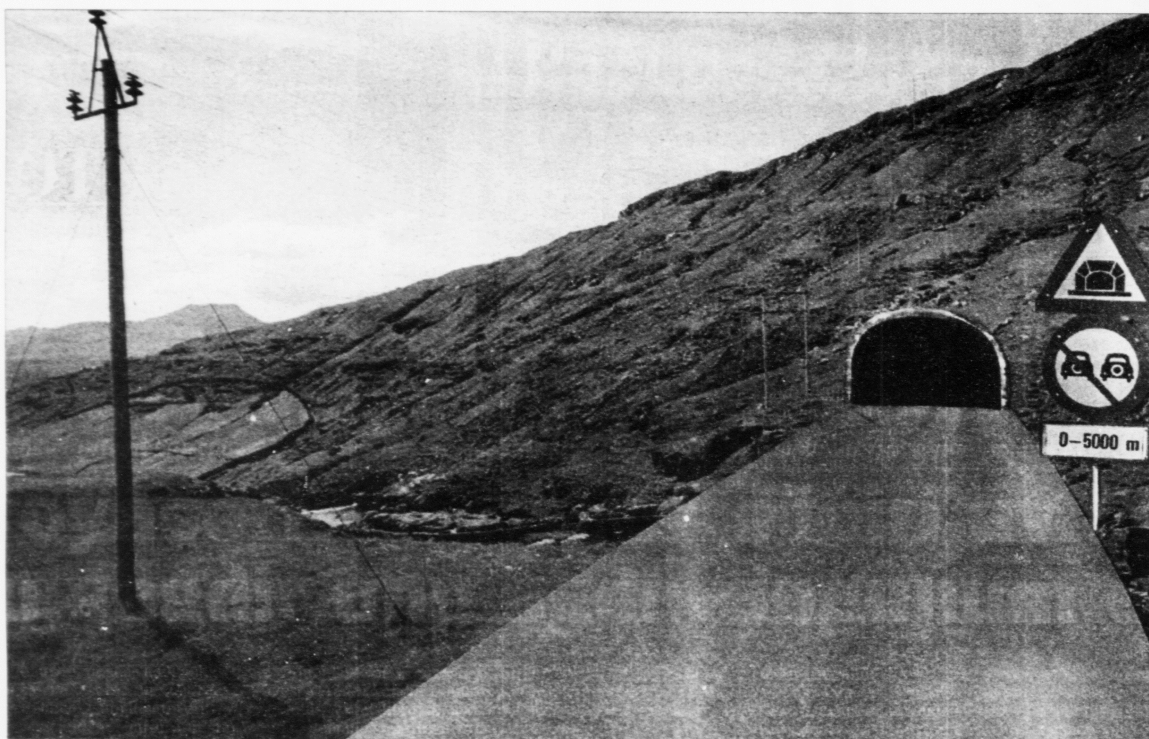
Fasta sambandið um Vestmannasund stendur ovast á skránni við nýløgum í vegakervið hjá bólkunum, sum hevur arbeitt við samferðsluúbyggingunum komandi ári.
