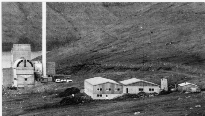
Hvør av øðrum liva má: Lýsivirkið í Leirvík er fyrsta virkið, sum fær avlops-hitan frá einum øðrum virki. Virkið fær avlops-hitan frá brennistøðini
