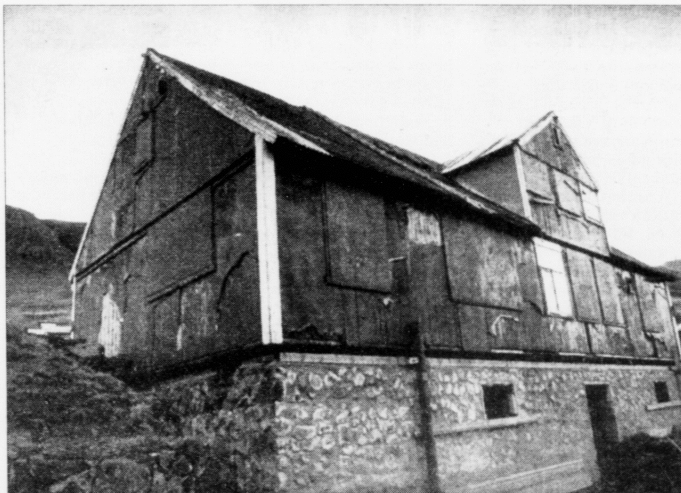
Húsinu áðrenn umvælingararbeiðið byrjaði
