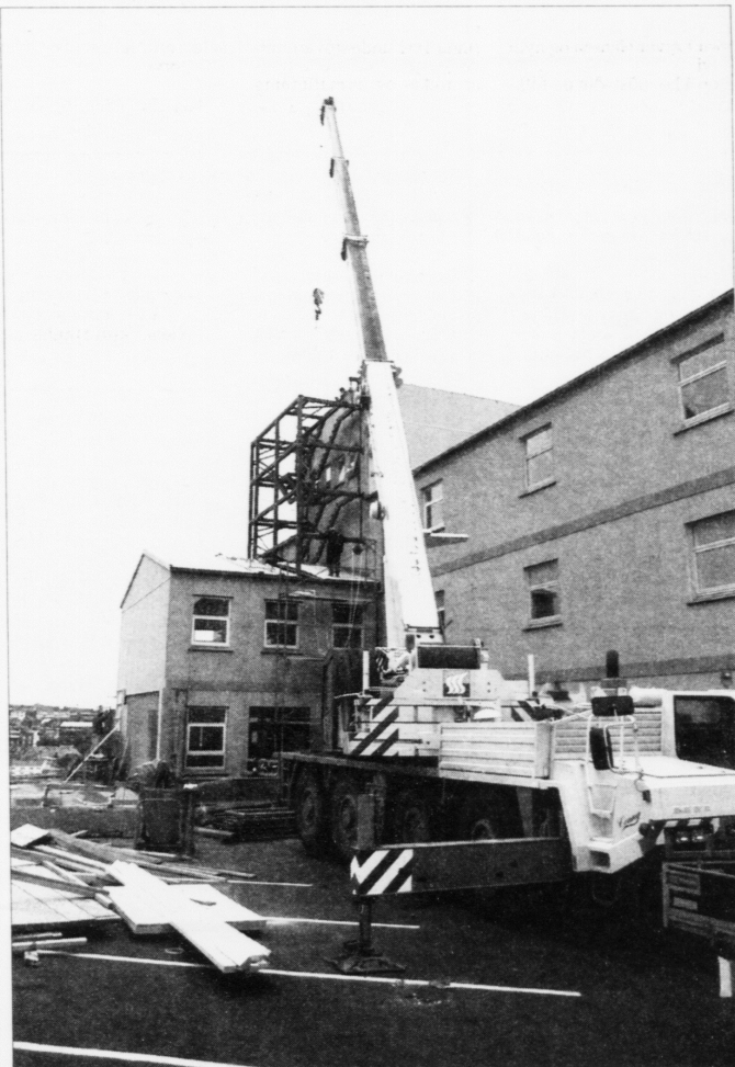
Skipasmiðjukurin setir stálkonstruktiónirnar til tornið upp (Mynd: Álvur Haraldsen)
