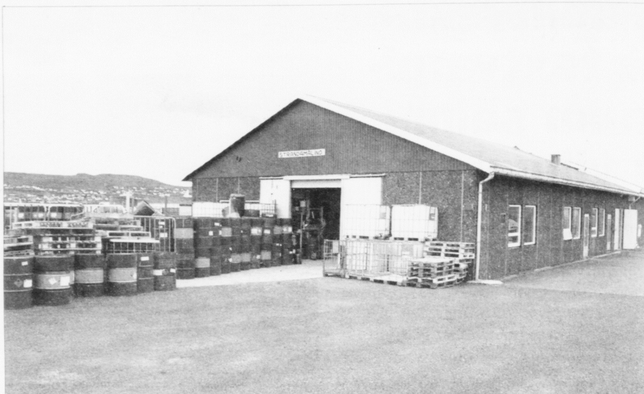
Afturat verandi virkisbygninginum hjá Stranda Máling á 400 fermetrar skal ein nýggjur bygningur byggjast, ið er 600 fermetrar stóur
