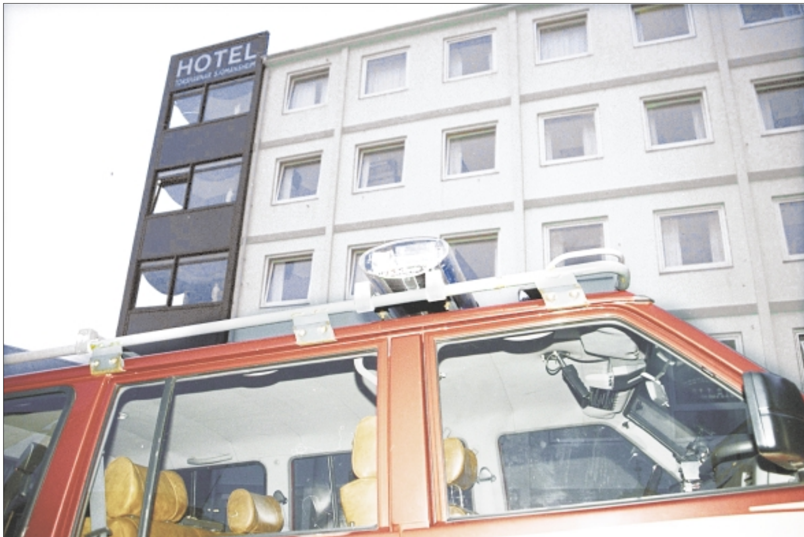
Stórur vatnskaði hendi á Hotel Tórshavn í Havn mánakvøldið, tá eitt vatnrør brast á 3. hædd Mynd: Jonhard Hammer
