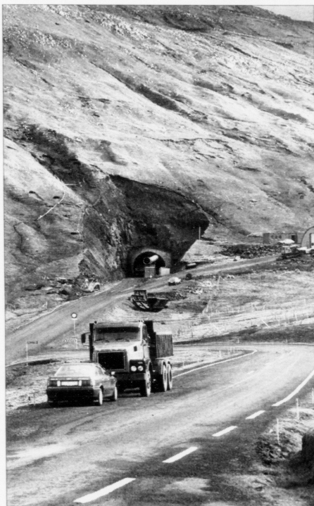
Tað, sum er eftir at gera í Sumbiarbergholinum, fer at kosta útvið fýra milliónir
