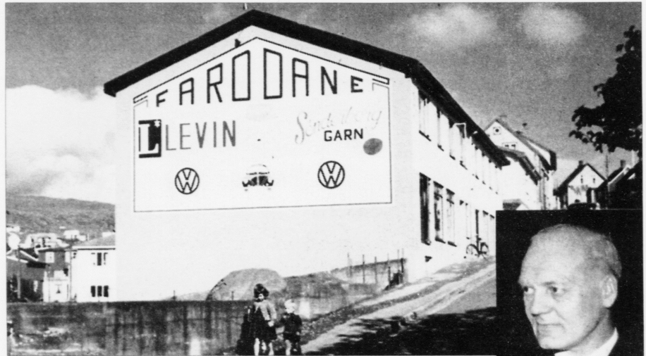
Í 1954 flutti Farodane inn í nýbygda virkisbygningin við Tinghúsvegin, har lýst varð á sunnara endaveggnum við ymsum vörum, eitt nú tógv og VW bilum. Fyrirtøkan var har til teir í 1980 fluttu niðan í Brekkutún 3 í Hoyvík.
