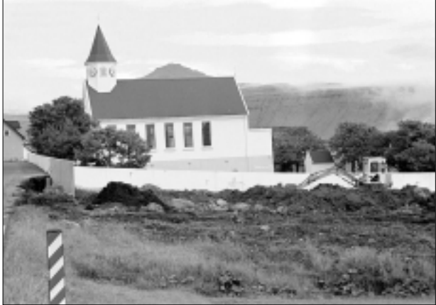
Arbeiðið við at byggja út kirkjugarðin á Skála er nú komið so langt, at bygðaráðsformaðurin væntar at tað verður liðugt um eina viku ella so. Og so verður aftur pláss í kirkjugarðinum.
