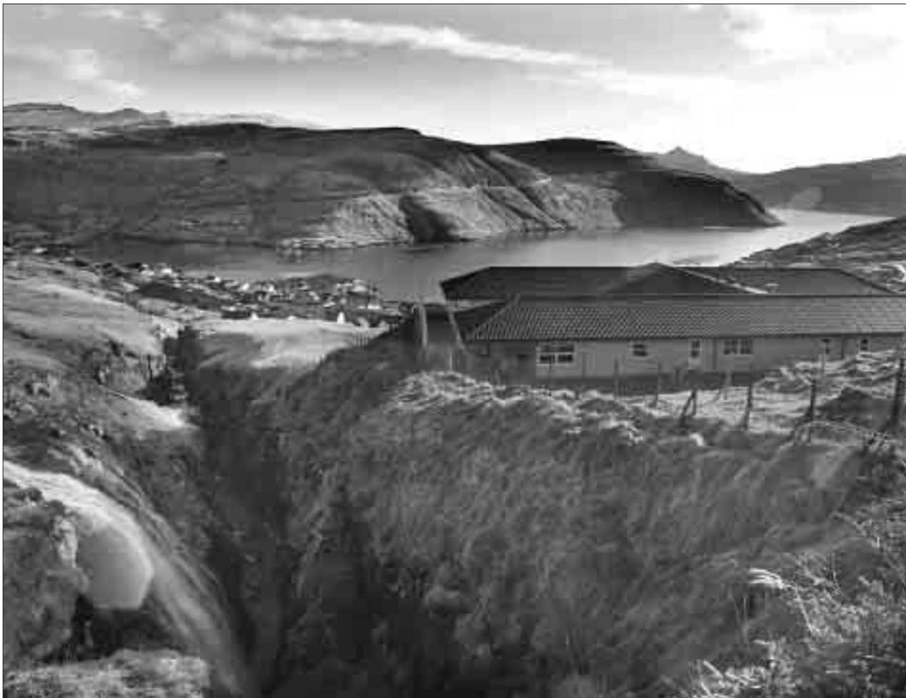
Nýggi barnagarðurin í Vestmanna liggur vakurt fyri. Við síðuna av barnagarðinum liggur djúp gjógv, men hegnað er framvið. Nú skal hegnast betri og tryggari kring allan barnagarðin
