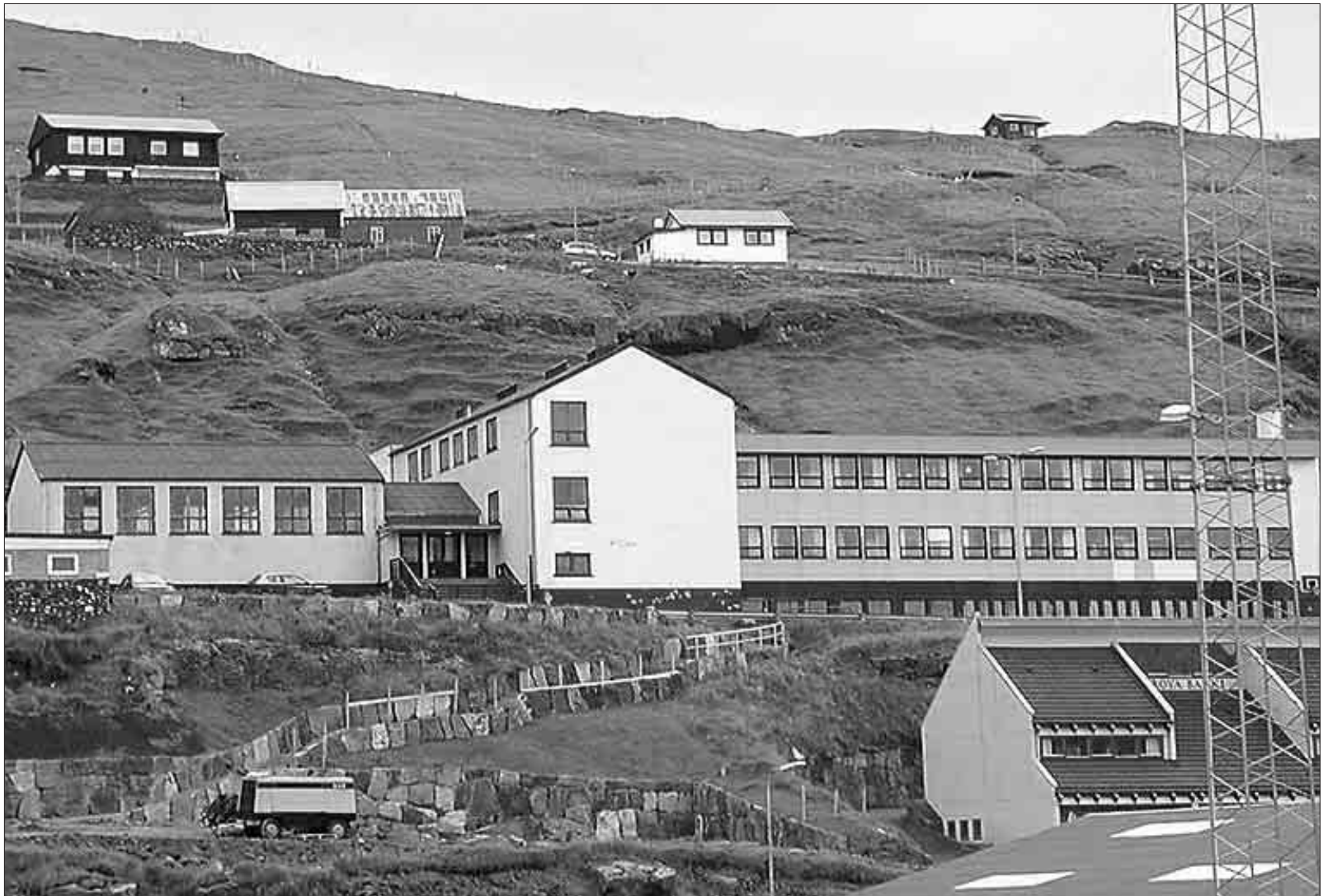
Spaki verður nú settur í til útbygging av Tofta skúla. Tað verður felagið, Falkon í Saltnesi, sum kemur at taka sær av lendisarbeiðnum, sum eisini fevnir um niðurtøku av gomlu fimleikarhøllini og burturflyting av gomlu læknahúsum norðanfyri skúlan
