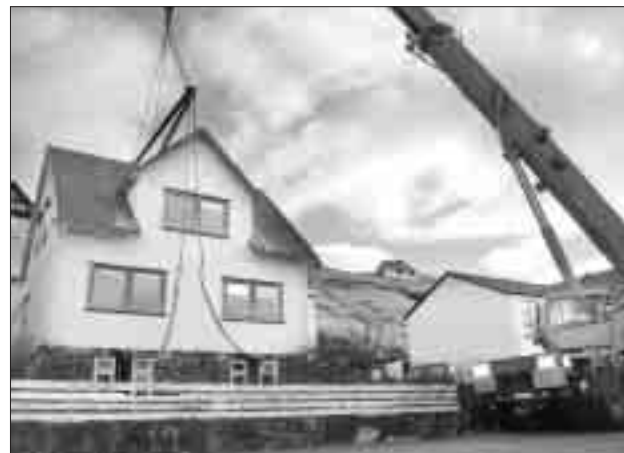
– Kranførarin sigur, at húsinu viga eini 18 tons, og tað er meira, enn vit frammanundan væntaðu, sigur Atli Poulsen, sum eigur fyrirkuna, AP Bilar & Maskinur. Hetta er fyrsta uppgávan av slíkum slag, sum felagið hevur átakið sær
