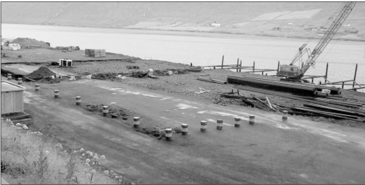
Eitt 15.000 fermetra stórt bryggju- og ídnaðarøki verður gjørt í Kollafirði úr tilfarinum úr undirsjóvartunnlinum
