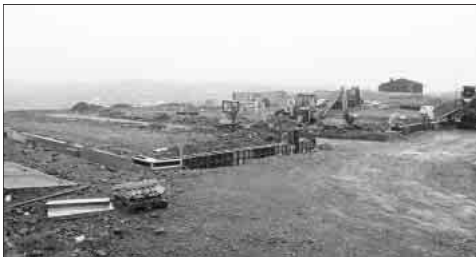
Arbeiðið at byggja nýggjan bygning á Hálsi til Elding er byrjað. Bygningurinn er 5000 fermetrar (Mynd: Bárður Lydersen)
