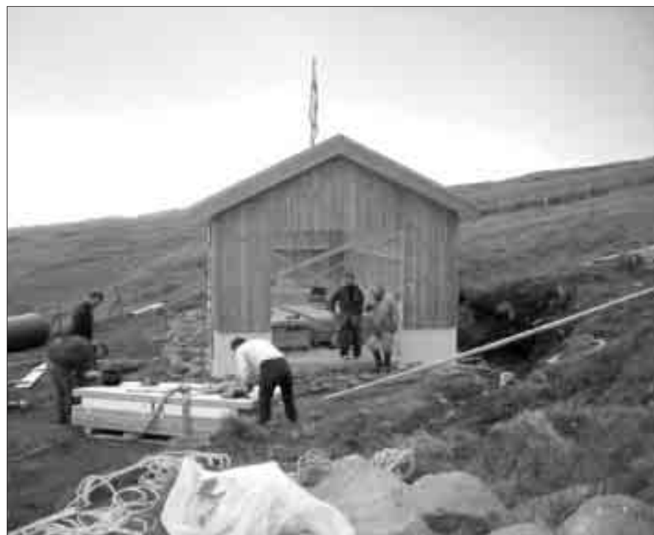
Nýggi bygningurin í Dímun er til motorar hjá SEV og til ymisk tól hjá bóndanum
